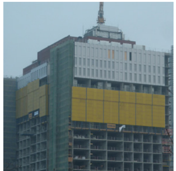
Ansicht auf das Gebäude des Bettenhochhauses im Zuge des Fassadenneubaus
