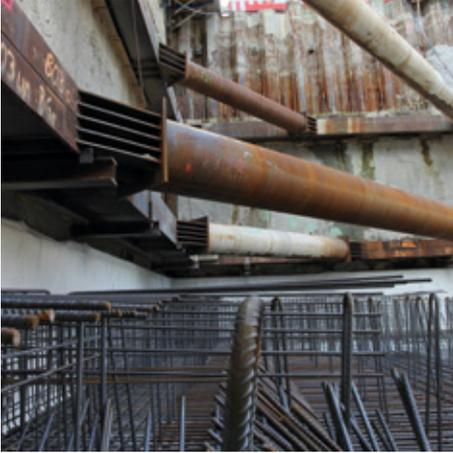
Eckaussteifungskonstruktion und Bodenplattenbewehrung
