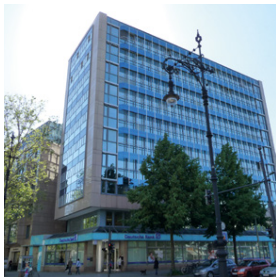
Fassade nach der Giebelöffnung
