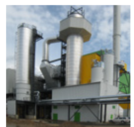
Rauchgasreinigung, Reststoffsilo, Kesselhaus
