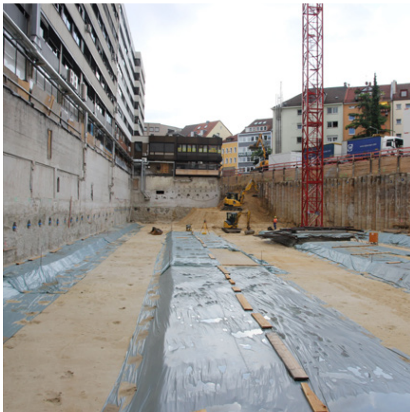
Blick in die fast fertig gestellte Baugrube
