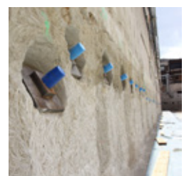
DSV-Unterfangungen mit Ankerköpfen
