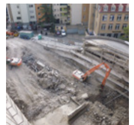
Abbruch bestehende Tiefgarage
