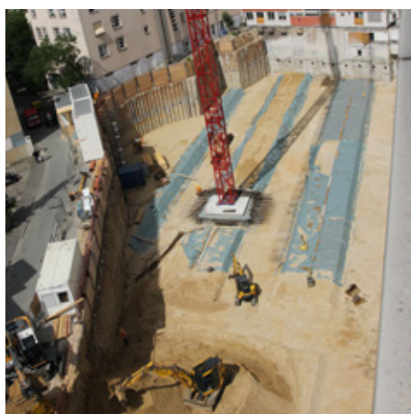
Blick von oben in die Baugrube
