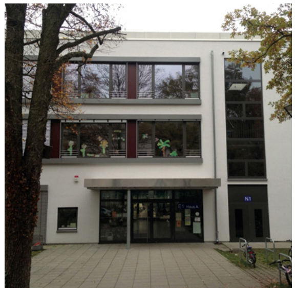
Abb. 1.: Haupteingang des Schulneubaus (Hauptgebäude)
