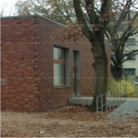
Abb. 2: Neubau Hortgebäude, Seiteneingang
