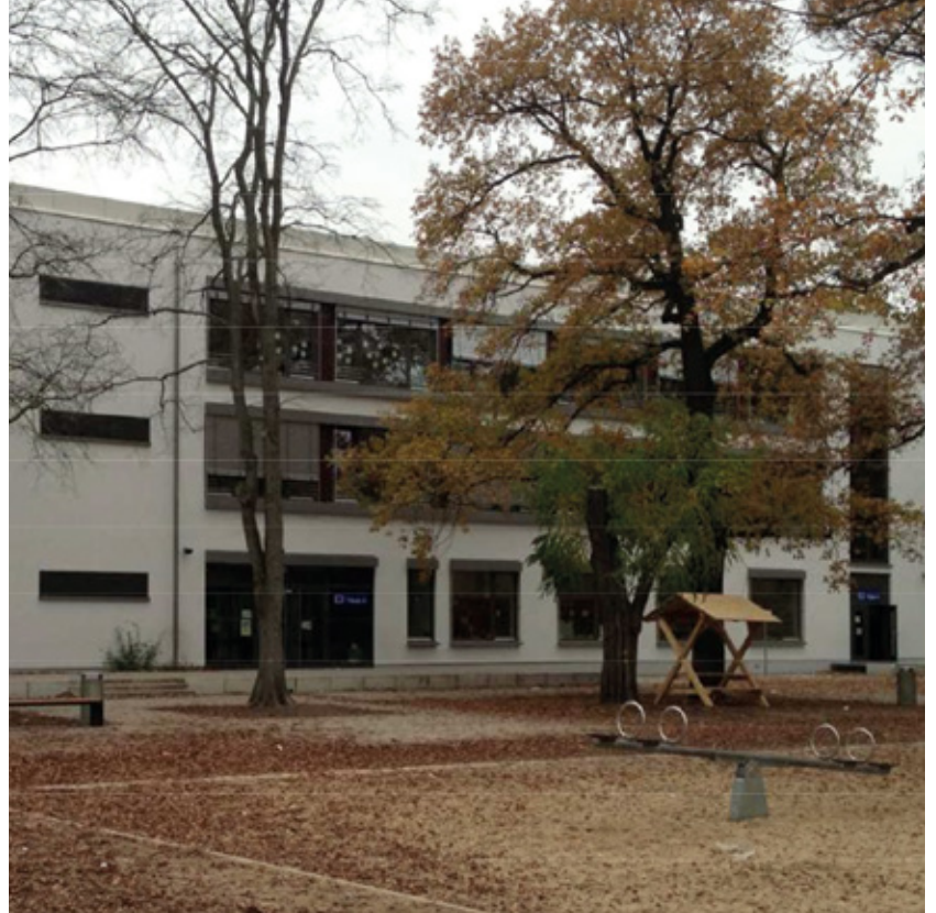
Abb. 4: Neubau, Ostfassade angrenzend an neu angelegten Schulhof
