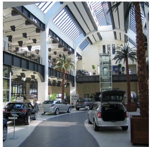
Abb. 1: Verkaufshalle nach der Sanierung
