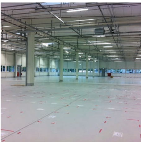
Abb. 8: Innenansicht der modernisierten Halle
