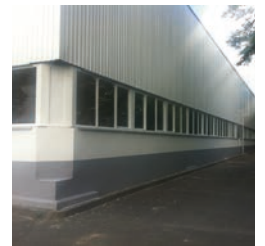
Abb. 6: Außenbereich nach der Modernisierung
