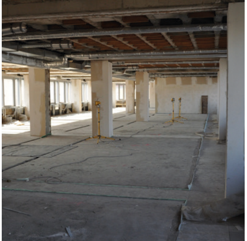
Abb. 2.: Entkerntes Geschoss vor der Sanierungsmaßnahme
