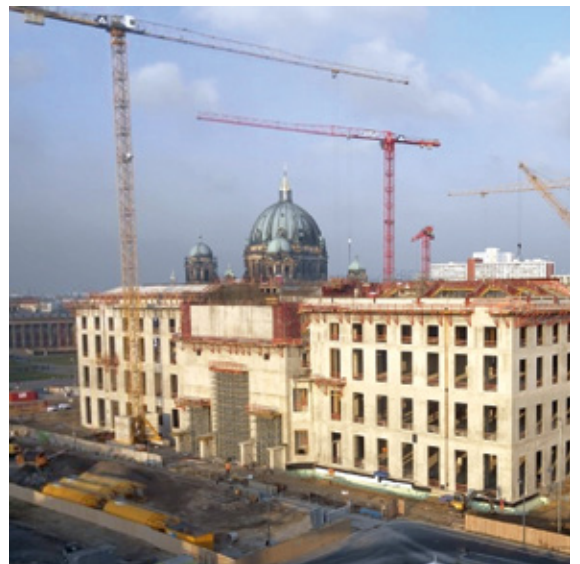
Ansicht des Rohbaus – Westfassade
