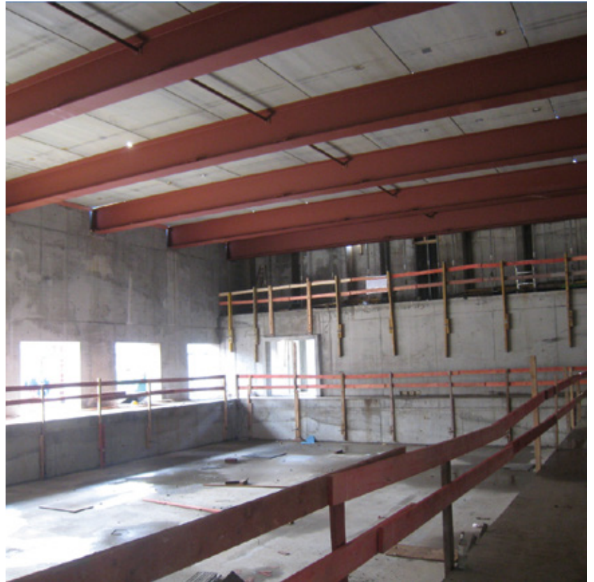
Detail Rohbau, Stahlträgerdecke
