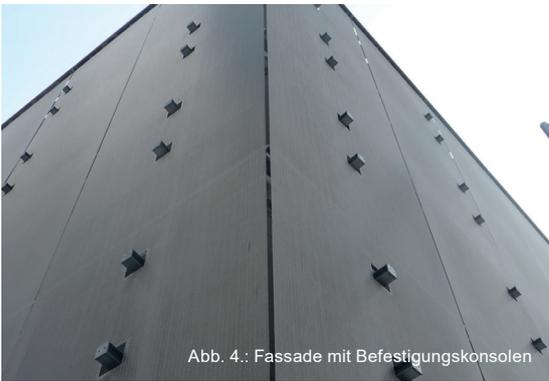
Abb. 4.: Fassade mit Befestigungskonsolen
